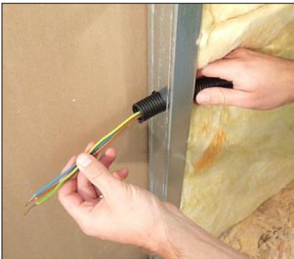
Construction ossature métallique Metal frame construction
